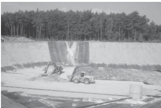
Abb. 5: Einbau BRM und Böschung.
