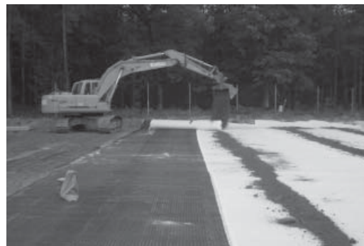
Abb. 6: Windsicherung Oberflächenabdichtung.
