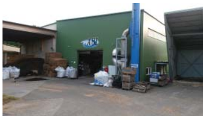
Abb. 2: Pilotanlage zur Torrefikation der Abfallbehandlungs-Logistik Frohnleiten GmbH mit Reaktorhalle und Abluftkamin, Materiallager (links) und Aufgabebunker (rechts)
