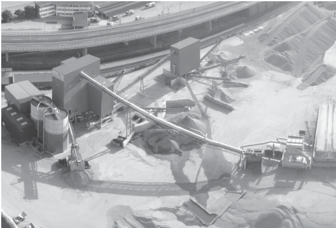
Abb. 3: ARGE Ground Unit am Gelände der voestalpine in Linz.
