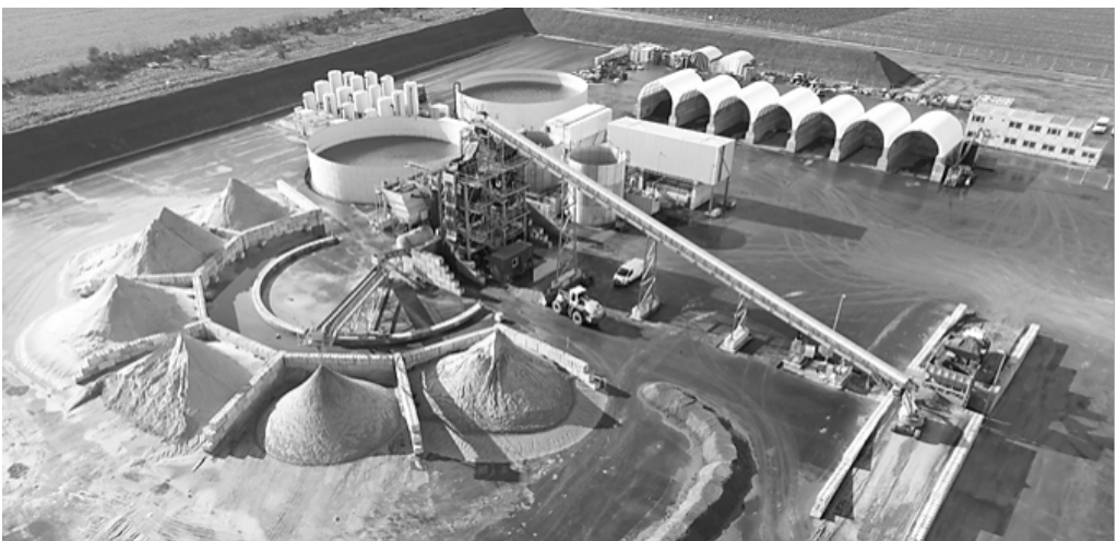
Abb. 1: Luftaufnahme der PFAS-Bodenreinigungsanlage in Norddeutschland
