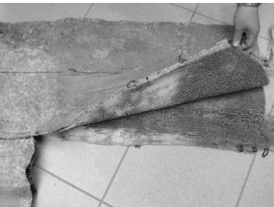
Abb. 3: Verockerung an gebogener KDE
