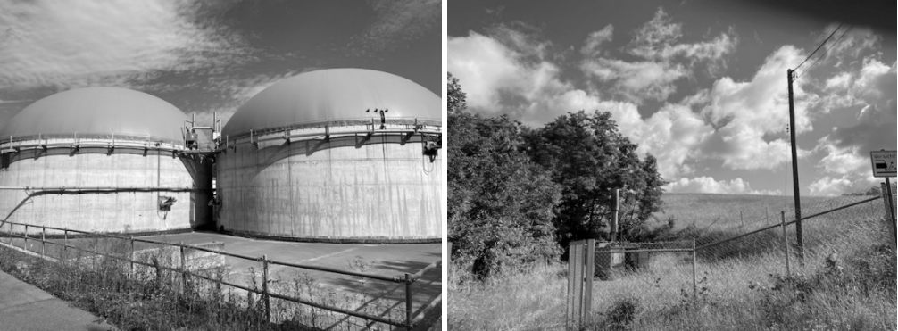
Abb. 1: Beispielhafte Abstände bei Biogasanlagen (Foto: Autor)
