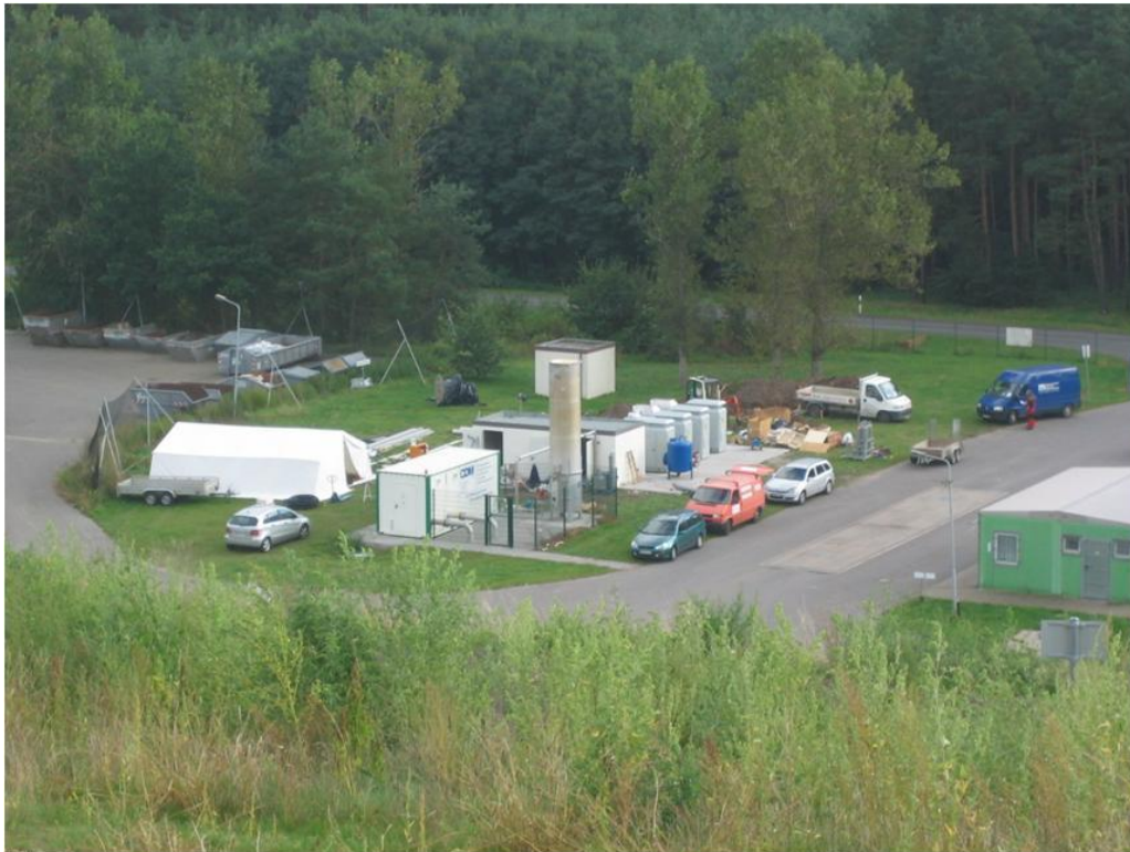
Abb. 2: MT-Anlage Deponie Werderberg, Bauphase 2007
