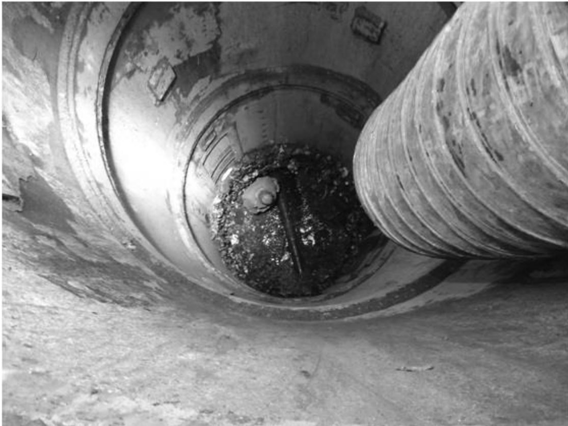
Abb. 3: Austausch eines Rohrkurzstückes im Schutze eines Stahlrohverbaus
