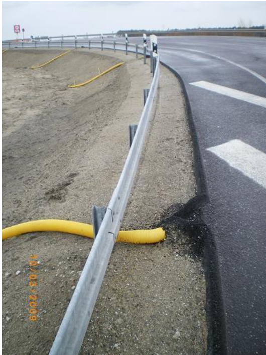
Abb. 13: Temporäre Wasserableitung im Straßenbau Abb. 14: Detail, Temporäre Wasserableitung
