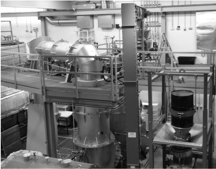
Abb. 4: Flash-Reaktor Pilotanlage im Technikum Thermoprozesstechnik
