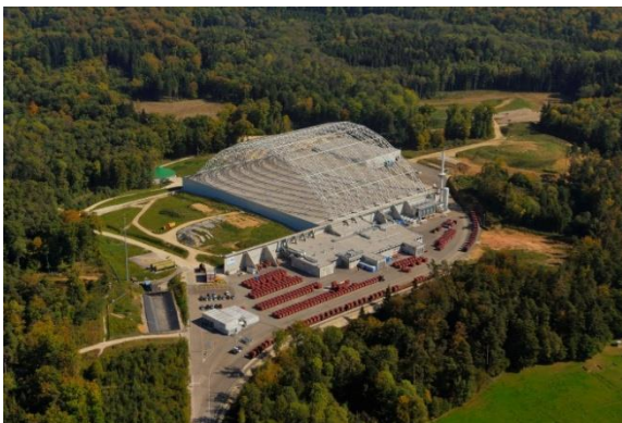
Abb. 3: Luftbild des Sanierungsstandorts in Bonfol: Die Aushubhalle, deren neun Stahlbögen das Dach tragen, wird für die zweite Sanierungsphase auf die andere Deponieseite verschoben.
