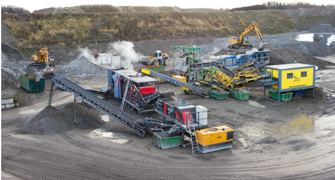
Abb. 1: Mobile Schlackeaufbereitungsanlage der AMR im Einsatz
