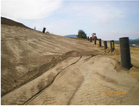
Abb. 7: Durch Fahrbetrieb verdichtete Oberfläche
