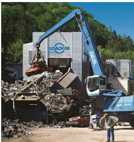
Abb. 1: Shredderanlage Loacker Recycling GmbH
