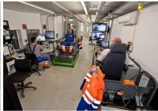
Abb. 4: Blick in die Leitwarte: Der Kran-Greifer, der die Abfälle aushebt, wird vom Maschinisten links bedient. Die beiden Mitarbeiter in den Baggersitzen bewegen ferngesteuerte Bagger in der Aushubhalle.
