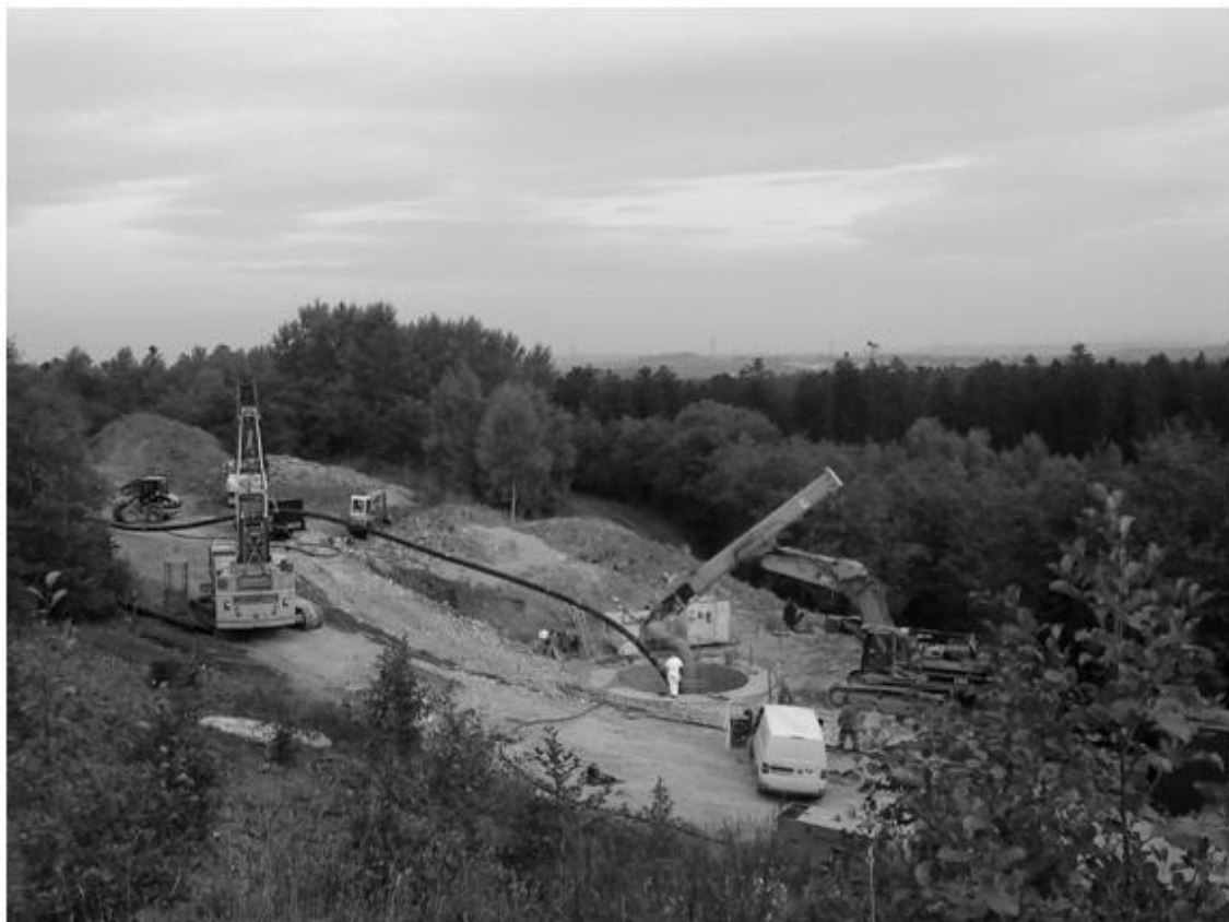
Abb. 5: Durchführung des dynamischen Berstlining-Verfahrens
