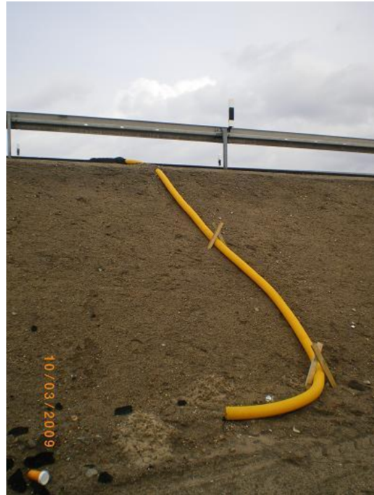
Abb. 13: Temporäre Wasserableitung im Straßenbau Abb. 14: Detail, Temporäre Wasserableitung
