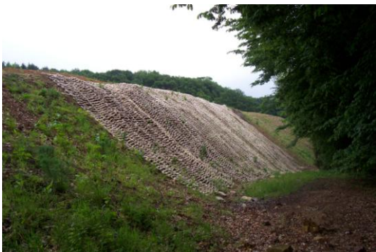
Abb. 19: Böschung mit Wollmatte (Skudelny 2011)
