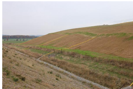
Abb. 16: Gezielte temporäre Wasserableitung
