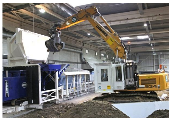
Abb. 2: Mai 2011: Der ferngesteuerte Bagger gibt die Abfälle in den Schredder, der Brocken zerkleinert und Gefäße öffnet. So wird das Explosionsrisiko für nachfolgende Arbeiten vermindert.
