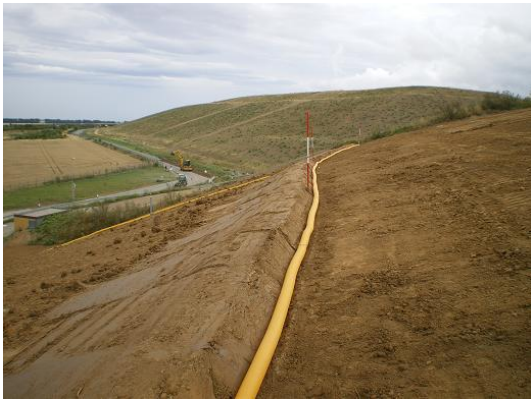
Abb. 15: Temporärer Damm zur Wasserfassung
